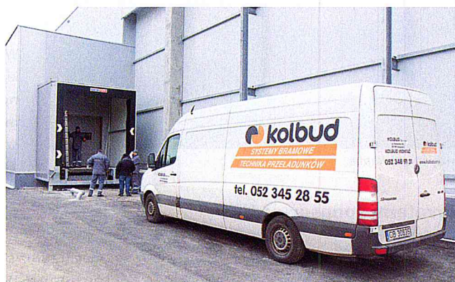
Prace montażowe firmy Kolbud
